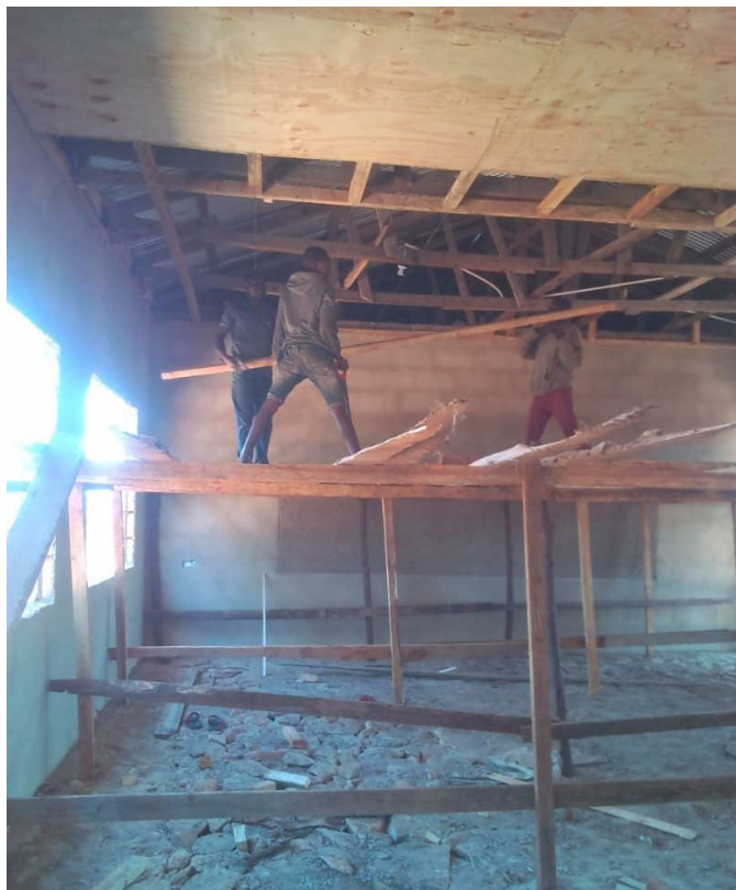
Am Gebäude für die Berufsausbildung geht es mit eigener Kraft voran
